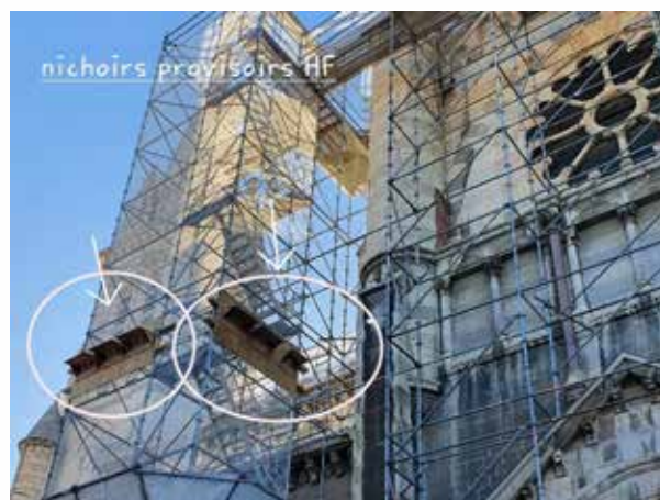
Nichoirs provisoires installés sur les échafaudages, Cathédrale St Arnoux, Gap, 2022, ©Valérie Vincent
